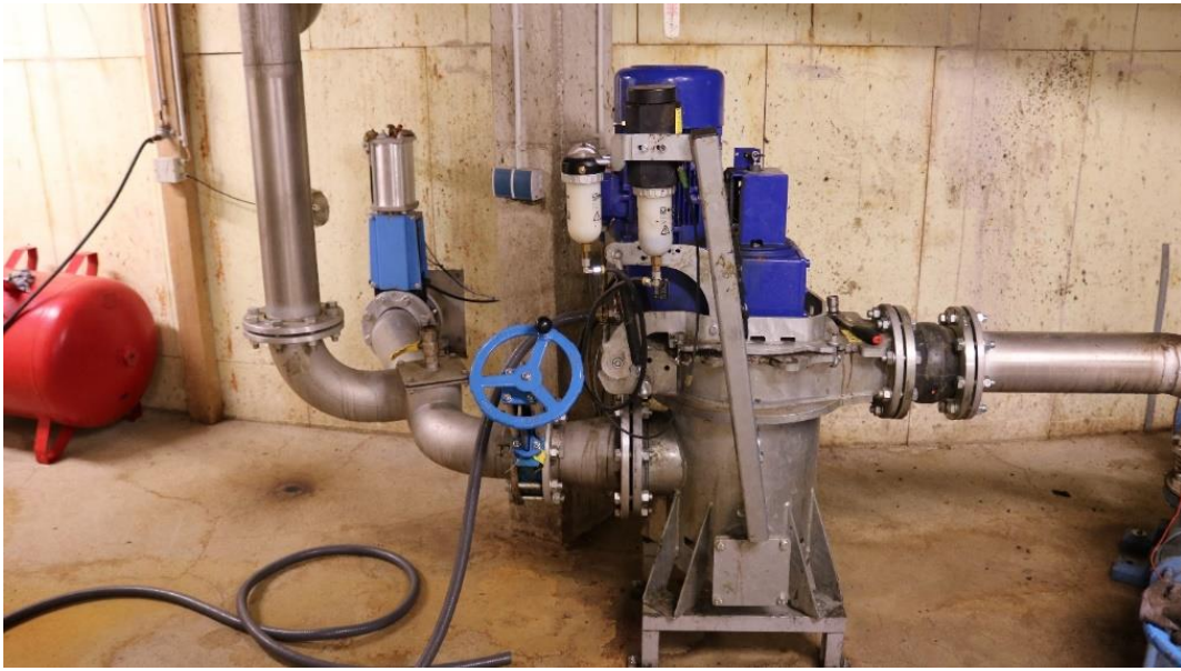
Abbildung 16 Substrat aus dem Fermenter wird durch den Cutter durch in das Heizsystem gepumpt.
