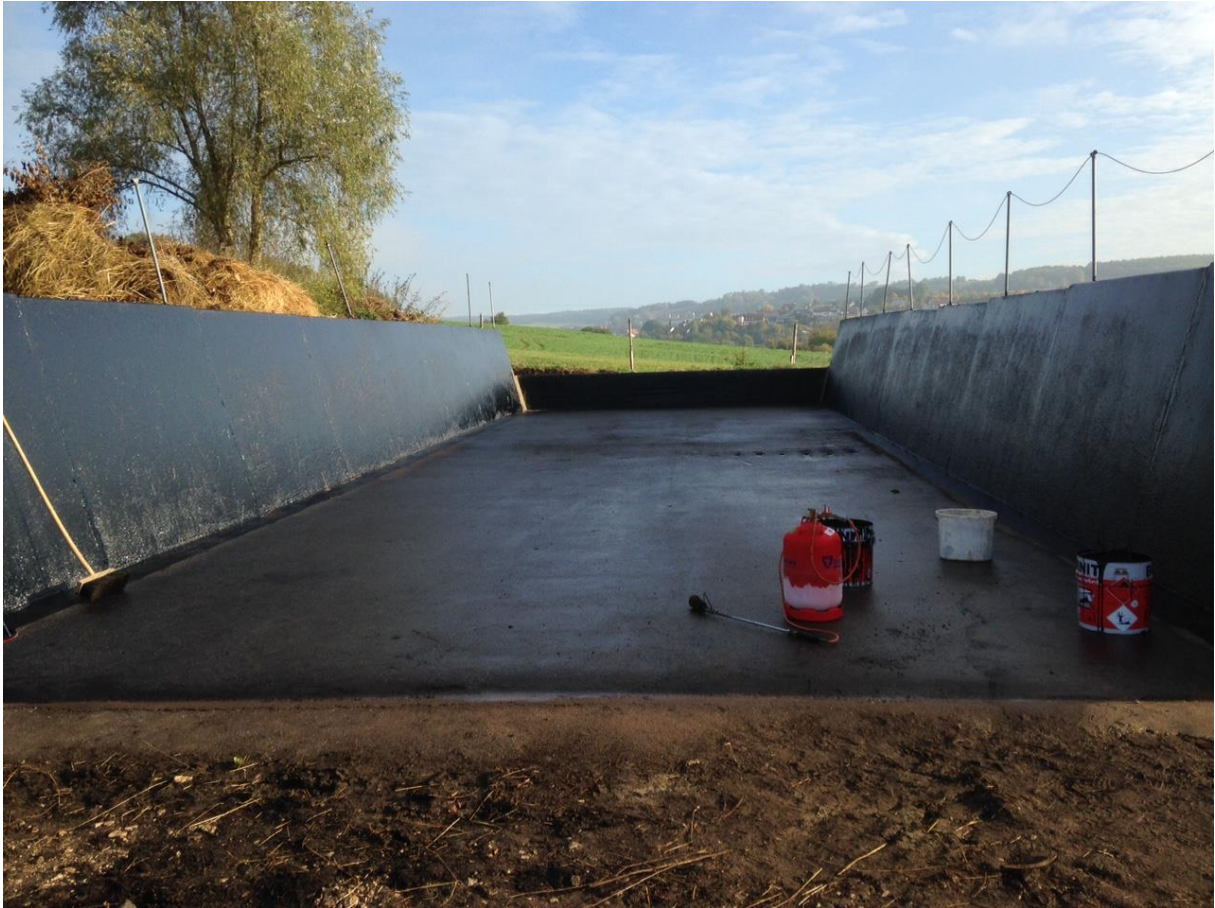
Abbildung 9 Um als Kompostieranlage genehmigt zu werden musste die Gemeinde die Flächen der Fahrsilos mit Speziallack isolieren und Fugen abdichten.
