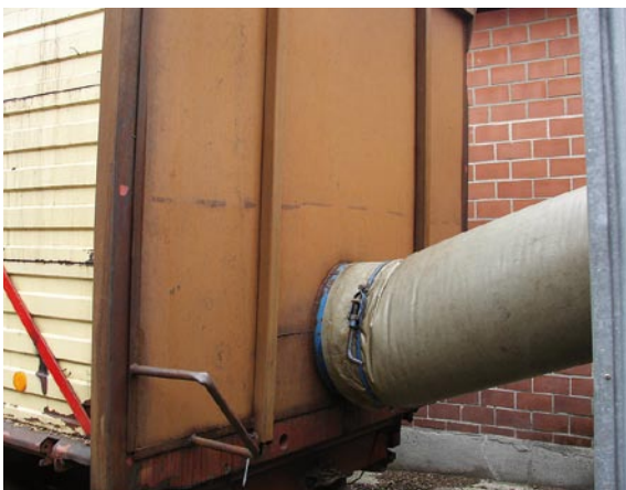
Trocknenwagen für die Hackschnitzel, erwärmt mit der Abwärme des BHKW.
