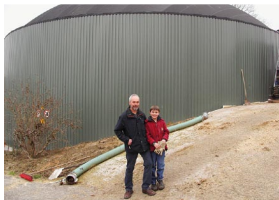
Bernd Egger mit Sohn vor dem Gärbehälter seiner Biogasanlage.
