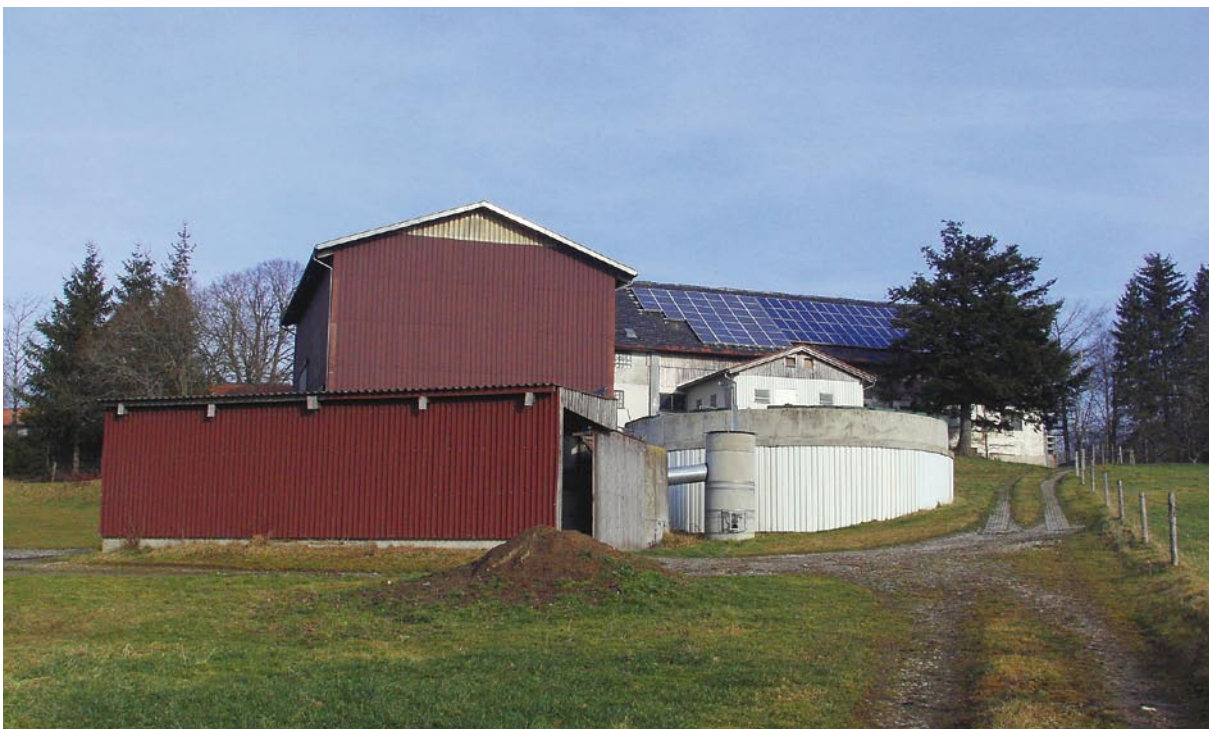
Biogasanlage des Betriebs Heubuch, Leutkirch.
